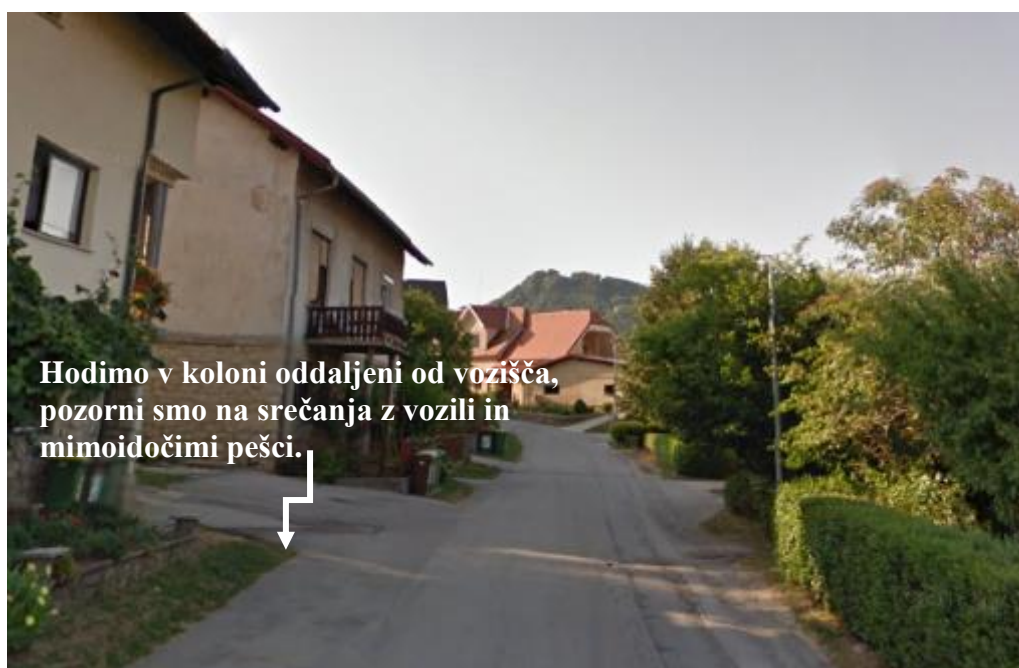
Slika 23: Neurejene površine za pešce na Trubarjevi ulici
